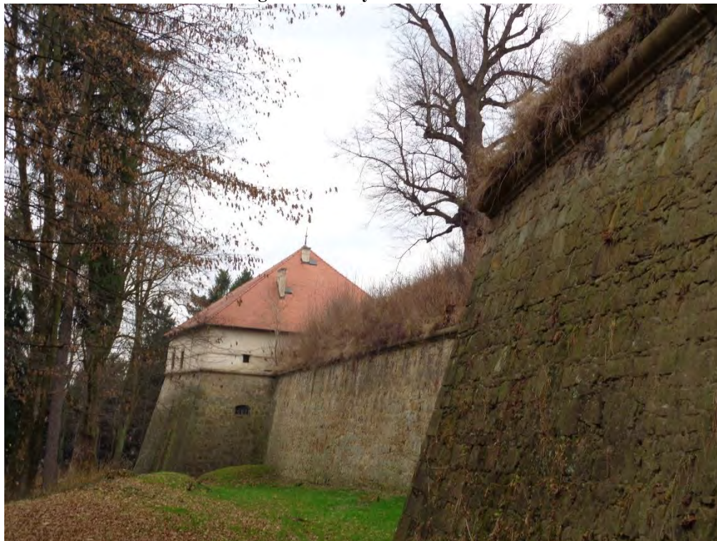
Fotografia 4 Mury obronne Zamku
