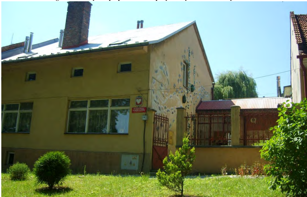
Fotografia 5 Budynek po przedszkolu przy ul. Rynek 33 w Nowym Wiśniczu
